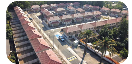
Condominio Los Ceibos Casas en Buin
